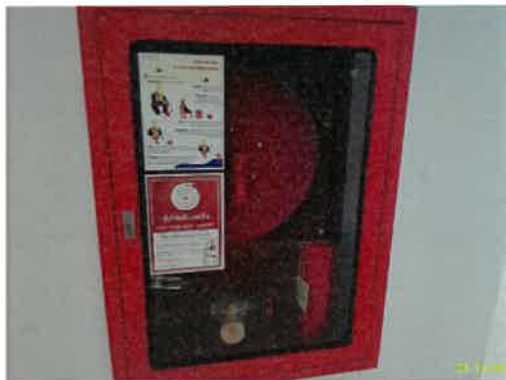
ตู้สายน้ดับเพลิง และป้ายบอกวิธีการใช้อุปกรณ์
