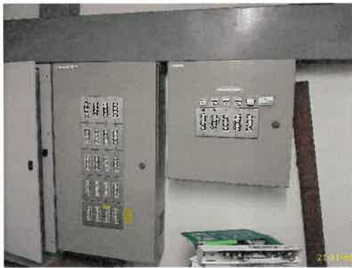
ตู้ควบคุมการเปิด-ปิดไฟส่องสว่าง
